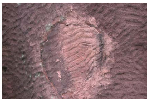
Vorzustand einer Altergänzung.
