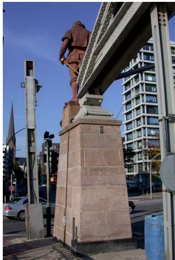
Zustand nach der Reinigung und Fugensanierung
