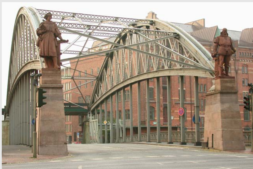
Zustand nach der Maßnahme im Oktober 2007
