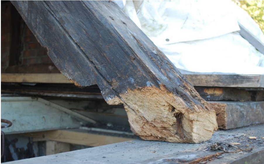
Abb. 37: Fußpunkt Sparren 1 b west: Die biotischen Schädigungen beschränken sich auf den oberflächennahen Bereich, ein Austausch ist nicht erforderlich.
