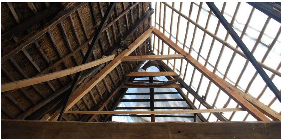
Abb. 58: Neu errichtetes Gespärre in Gebinde VIII
