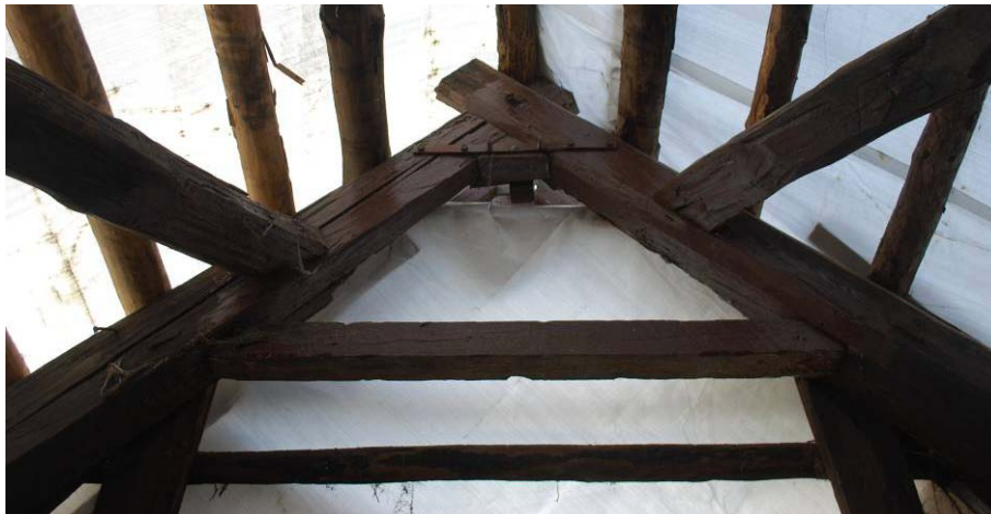
Abb. 34: Südl. Giebelspitze, Gebinde 1 b: Die hier vorliegenden Befallsspuren durch Hausbock ( Hylotrupes bajulus ) weisen auf einen erloschenen Befall hin. In den Fluglöchern ist dieselbe braune Anstrichfarbe wie an den Sparren nachweisbar; frische Löcher waren nicht nachweisbar. Ein Austausch ist nicht erforderlich.
