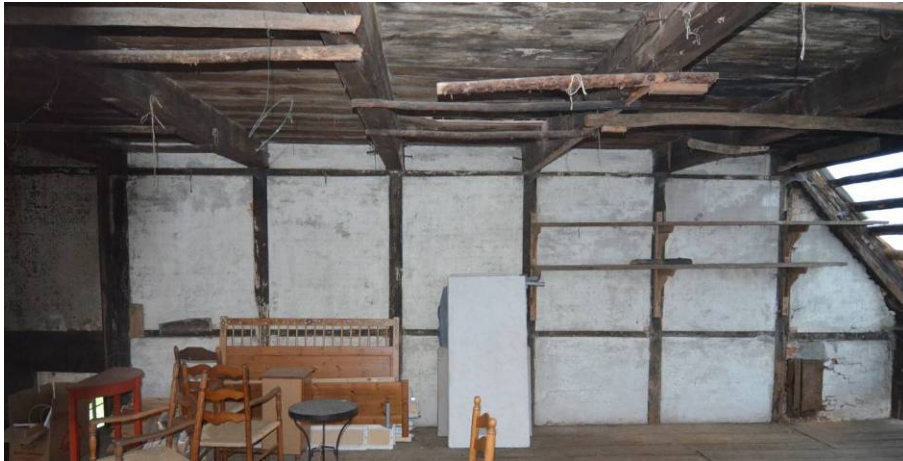
Abb. 29: Raum 11, Südwand und Decke: An den Deckenbrettern sind wegen jahrelanger Durchfeuchtung (Dach undicht) teils gravierende Schäden entstanden. Es liegen aktiver Pilz- und Nagekäfer-Befall vor.
