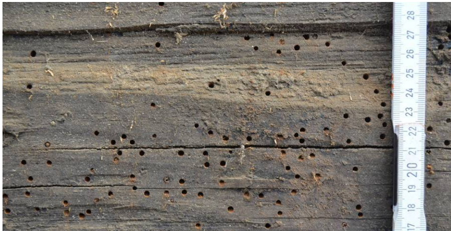
Abb. 64: Beispielhafte Holzoberfl. bei starkem bzw. langandauerndem Befall durch Gescheckte Nagekäfer (hier am Balken von Geb. VIII, Südseite)
