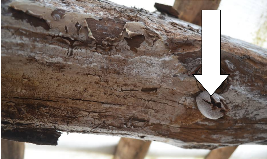
Abb. 45: Partiiell flächig von Nassfäule-Pilzen bewachsener Aufschiebling (Gebinde IIII west) mit einzelnen Fruchtkörpern höherer Pilze (Pfeil; Art nicht näher bestimmt).
