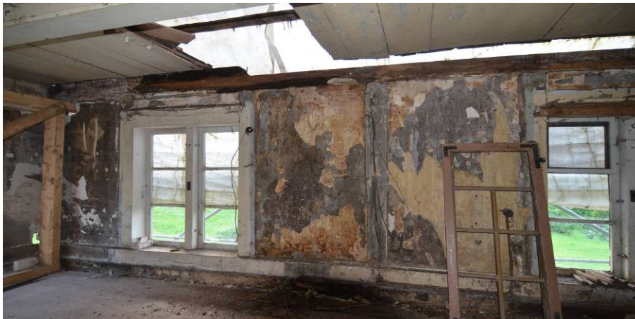
Abb. 26: Raum 5 Westwand, mit zerst. Oberrähm (während der Bearbeitung / Teilerneuerung)
