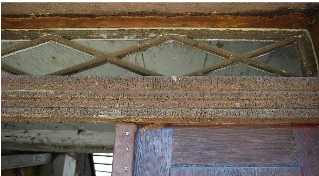
Abb. 06: Ostfassade, Detail Haustür: Oberlicht
