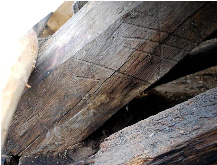
Abb. 42 und 43: Abbundzeichen auf dem westl. Aufschiebling in Gebinde IIII. Rechts Skizze
