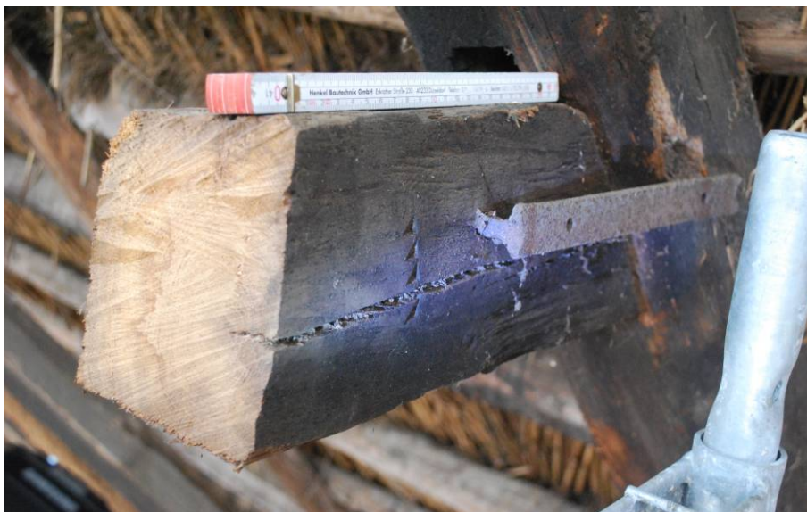
Abb. 60: Gebinde VIII, abgesägter Hahnenbalken mit Abbundzeichen (4 Ausstiche)
