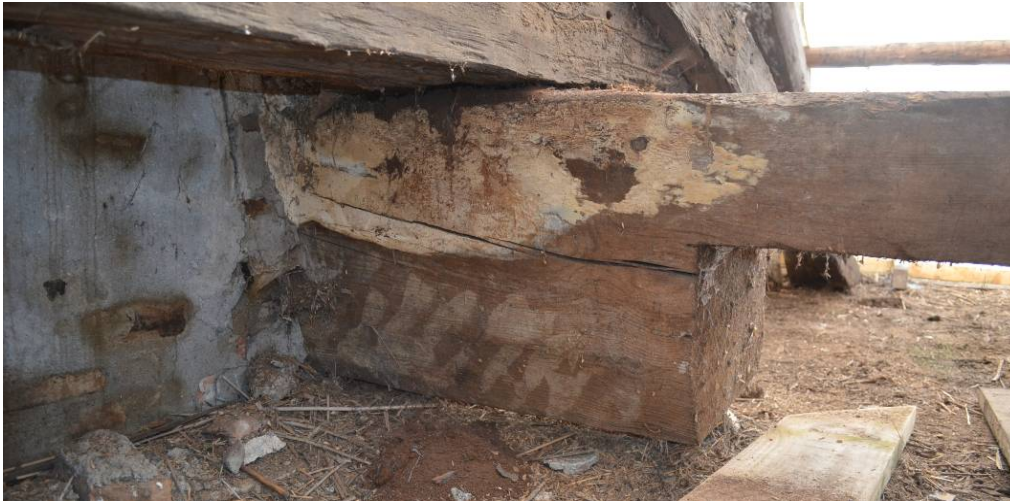
Abb. 76: Befall durch Feuerschwamm am Unterzug in Gebinde V, Westseite
