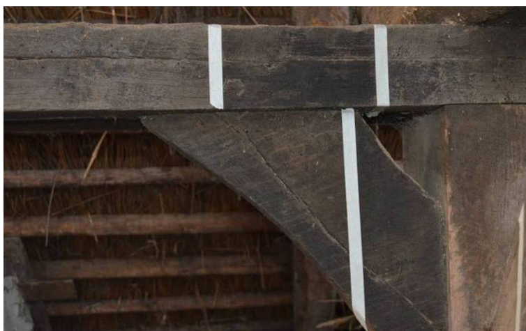
Abb. 100: Trockenreinigungs-Proben am südl. Kopfband und Rähm in Gebinde VI
