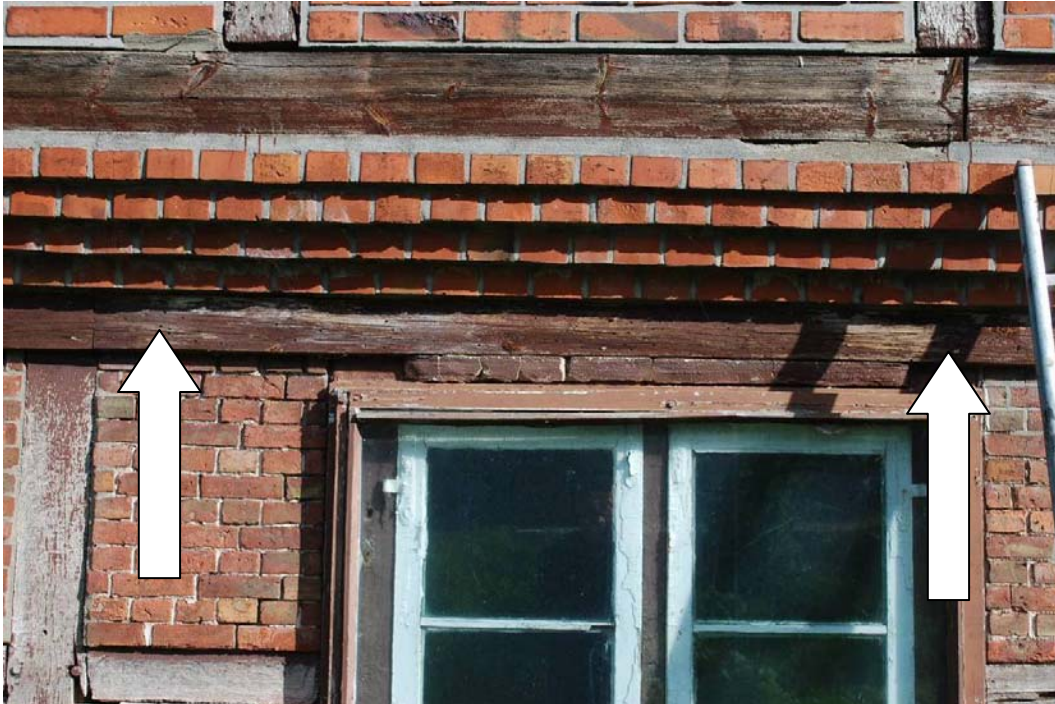
Abb. 12: Südseite EG, Oberrähm Gebäudemitte. Das eigentliche Rähm ist mit Bohlen beplankt und (noch) nicht einsehbar.
