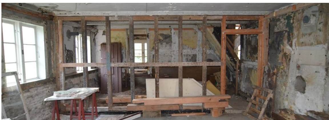
Abb. 25: Trennwand zw. 04 a und 04 b
