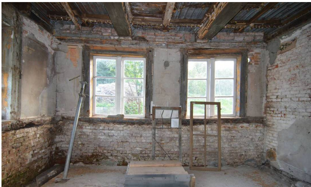
Abb. 15: Raum 3, Südwand, entspr. östl Seite der Südfassade.
