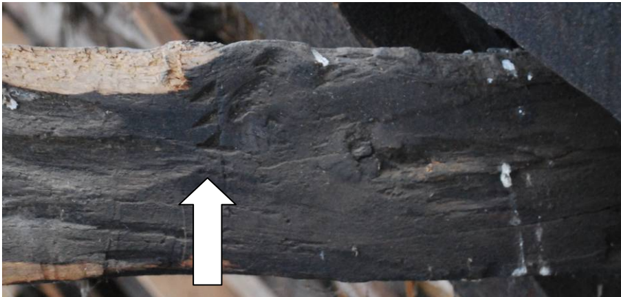
Abb. 53: Abbundzeichen am Hahnenbalken in Geb. VII, Nordwest-Seite
