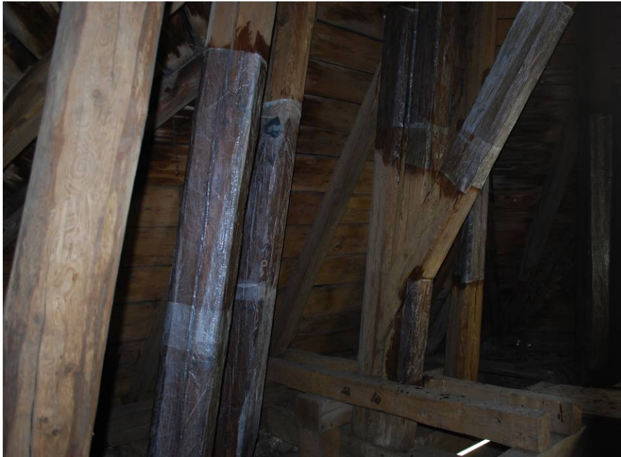
Abb. 98: Beispiel für zu Monitoring-Zwecke abgeklebte Balken
