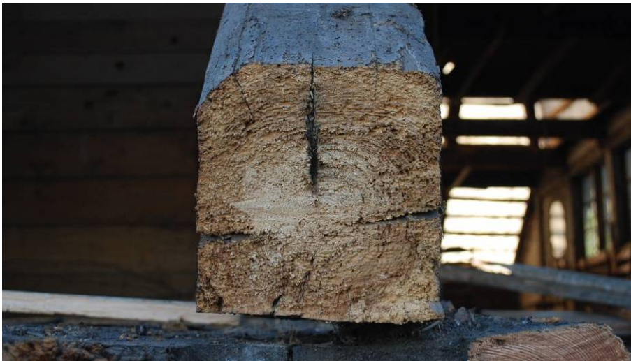
Abb. 38: Fußpunkt von Sparren 1 a west nach Rückschnitt des zerst. Kopfes
