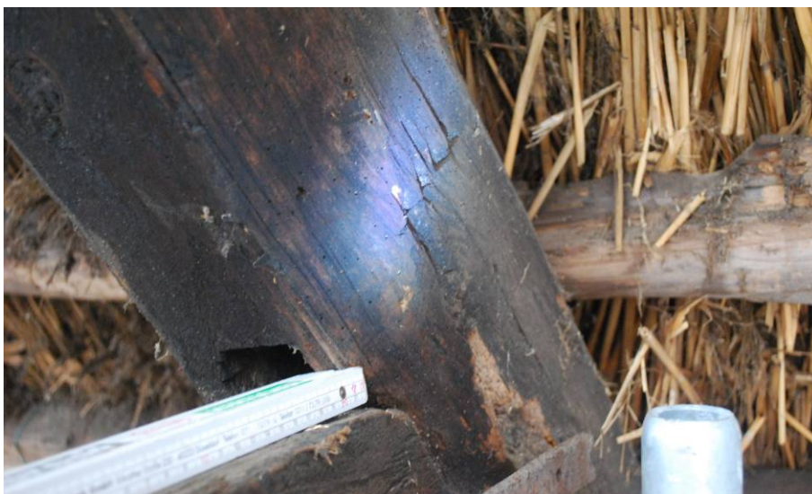
Abb. 61: Gebinde VIII, Sparren neben abgesägtem Hahnenbalken mit Abbundzeichen (4 Ausstiche)
