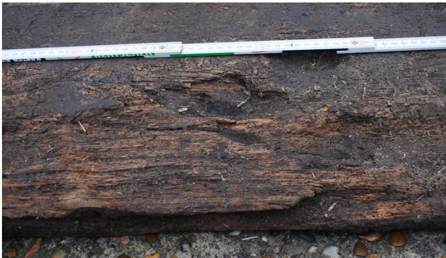
Abb. 29: Raum 11, Südwand und Decke: An den Deckenbrettern sind wegen jahrelanger Durchfeuchtung (Dach undicht) teils gravierende Schäden entstanden. Es liegen aktiver Pilz- und Nagekäfer-Befall vor.
