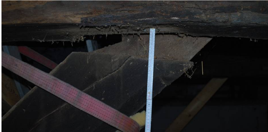
Abb. 55: Geb. VII ost: Offene Verbindung zw. Balken und Kopfband. Das Kopfband kann in die Blattsasse zurück gesetzt werden.
