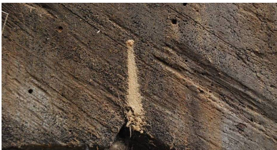
Abb. 81: Auf der Suche nach den Larven des Gescheckten Nagekäfers von Blauen Fellkäfern (oder deren Larven) ausgeworfenes Bohrmehl.
