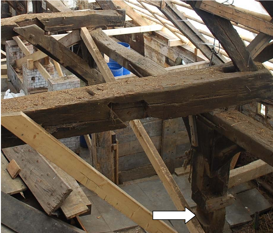
Abb. 48: Vordergrund: Gebinde VI – Rekonstruktion von Kopfband u. Hillriegel sowie Ausklotzung der nicht benötigten Ausnehmungen (Pfeil) empfohlen. Hintergrund: Geb. VII – Wiederbefestigung Kopfband, weiteres analog zu VI
