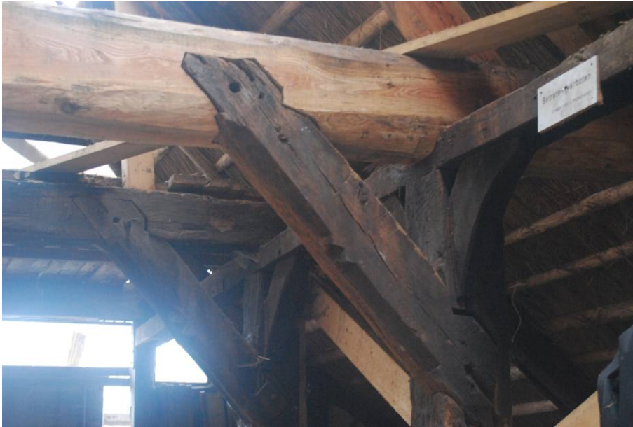
Abb. 62 Gebinde VIII, Bestands-Kopfband eingebaut in erneuerten Balken
