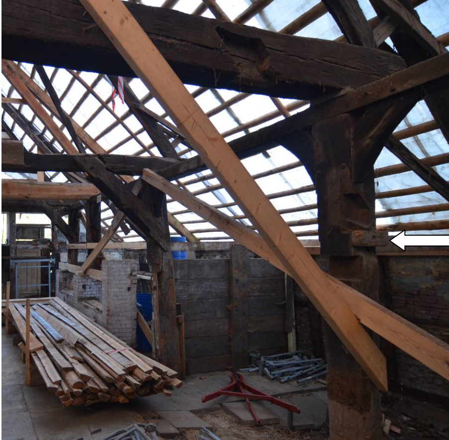
Abb. 47: Geb. VI Ost: Zahlreiche Ausnehmungen u. Blattsassen am Ständer von 1547. Soweit möglich und im denkmalpflegerischen Gesamtzusammenhang sinnvoll, werden fehlende Bauteile ersetzt. Hier: Kopfband und Hillriegel. Nicht benötigte Anbauten ohne nennenswerten geschichtl. Zeugniswert werden entfernt (Pfeil), die historische Ergänzung am Fußende soll erhalten werden.
