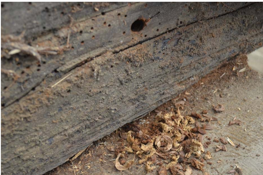
Abb. 44: Gebinde IIII, Balken west. Zur Prüfung der verbliebenen Holzfestigkeit bzw. des Restquerschnitts wurden Bohrungen (d 10 mm) angebracht. Im Bild ist am Bohrmehl erkennbar, dass die äußeren cm weitgehend gesund sind (helle Bohr-Späne), das Holzinnere dagegen ist pilzlich abgebaut (dunkle, krümelige Späne).
