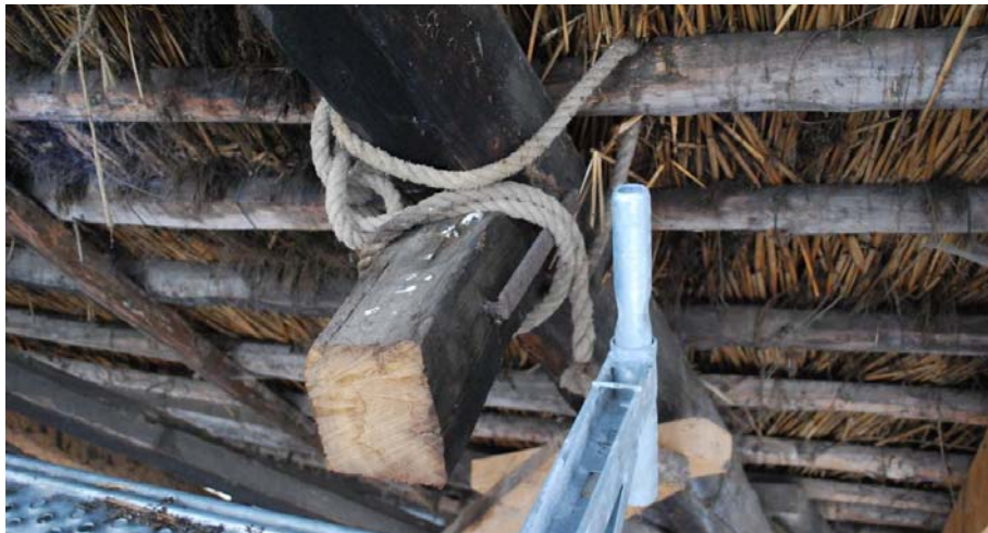
Abb. 59: Gebinde VIII, abgesägter Hahnenbalken
